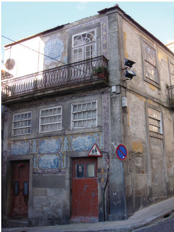
Figura: 4.7 Casa revestida a azulejos setecentistas | Fonte: do autor
